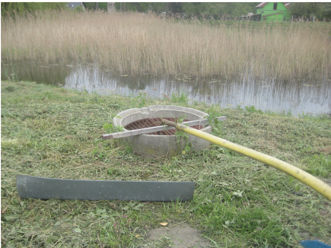
Fot. 8. Ujęcie przeciwpożarowe Up-1
