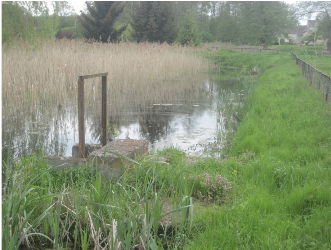
Fot. 3. Mnich spustowy MNm-4
