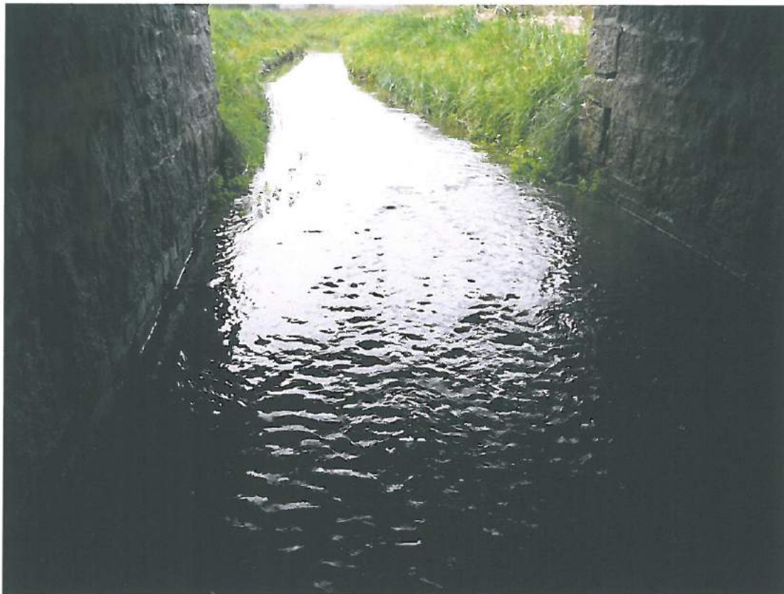
Fot. 7. Koryto ciekę pod obiektem, widoczna porastająca roślinność na skarpach.
