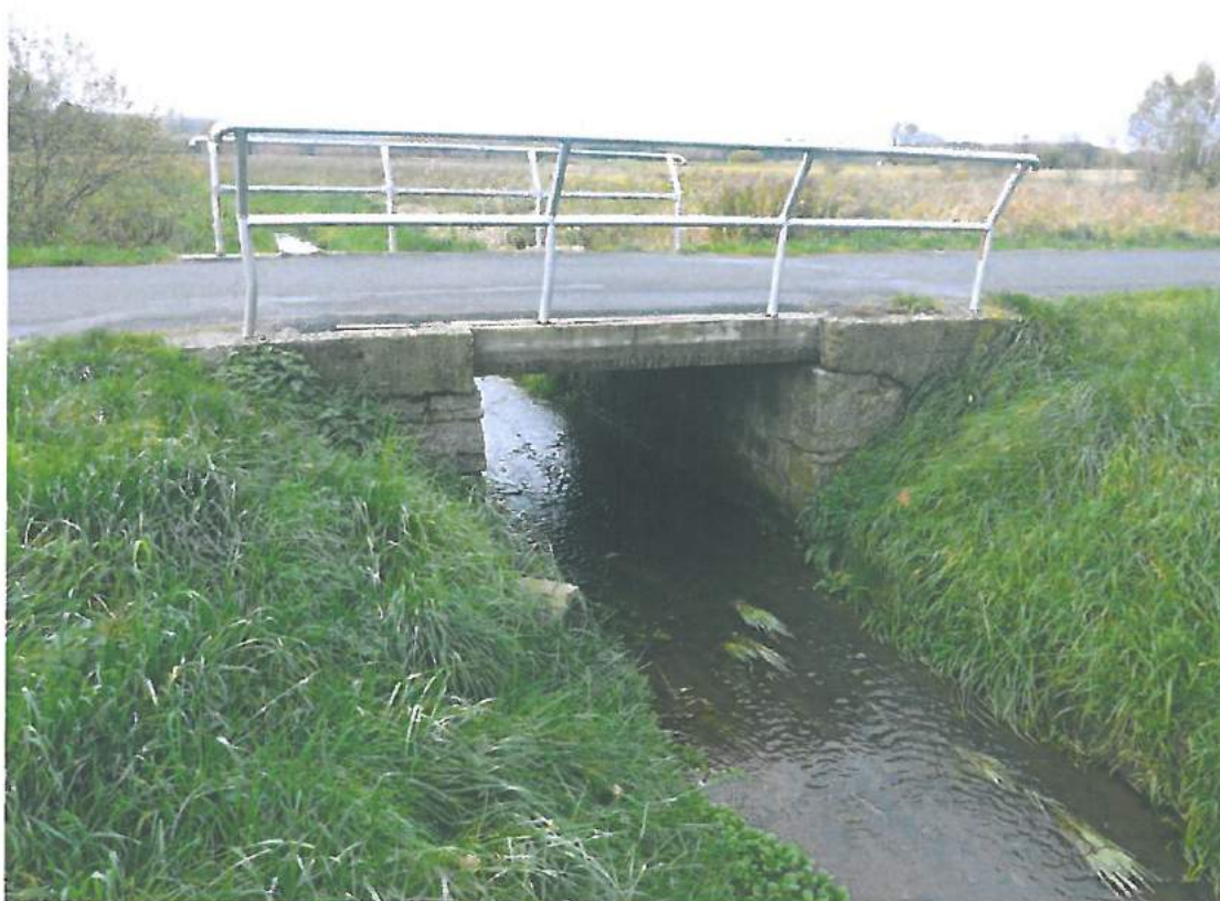
Fot. 5. Widok konstrukcji z boku od strony dolnej wody. Widoczne kamienne przyczółki oraz nadbudowane skrzydełka z betonu.
