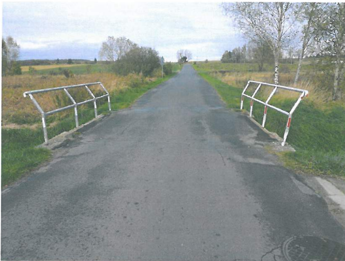
Fot. 1. Część przejazdowa obiektu - widok od strony centrum Rudnej.
