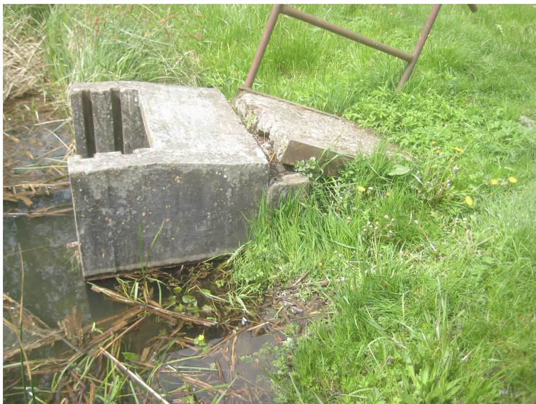
Fot. 9. Wlot do zbiornika wodnego „Przychowska Struga”
