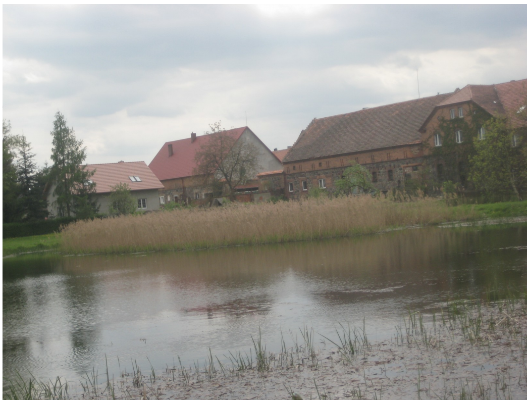
Fot. 4. Widok na zbiornik
