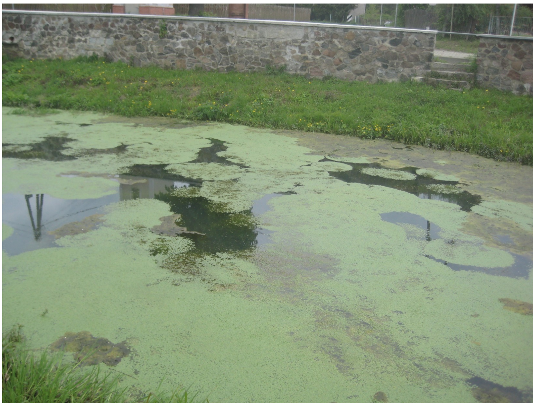
Fot. 2. Widok na zbiornik
