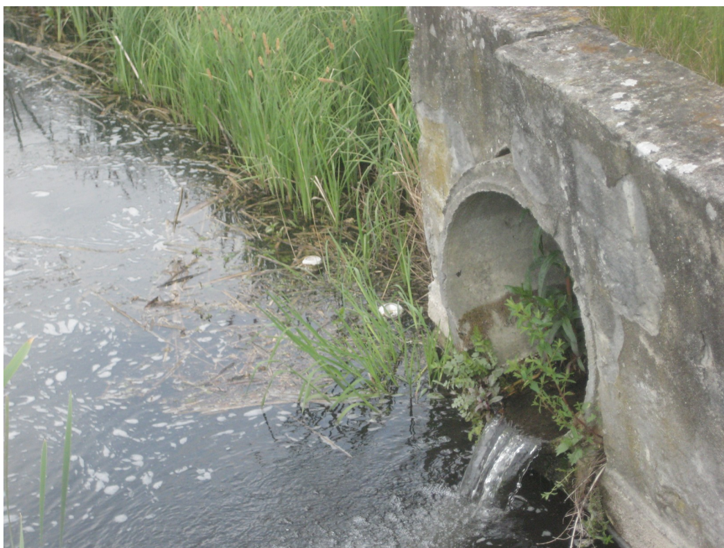
Fot. 3. Wlot betonowy do zbiornika
