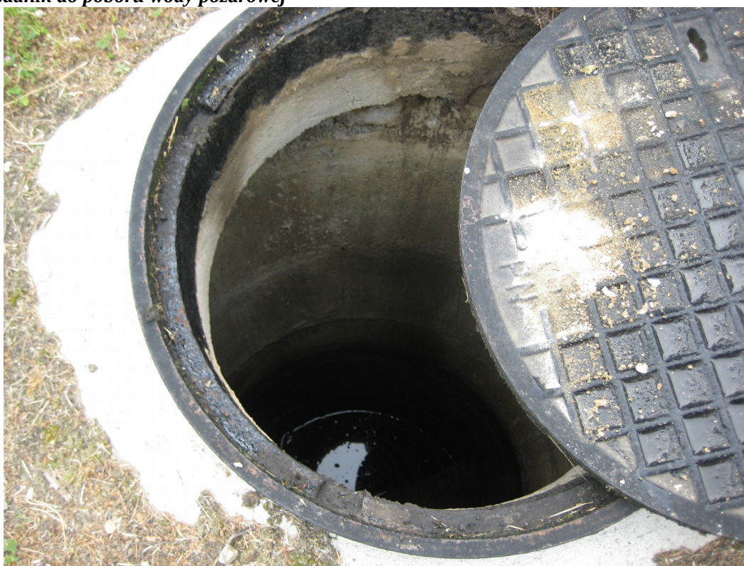
Fot. 6. Osadnik do poboru wody pożarowej
