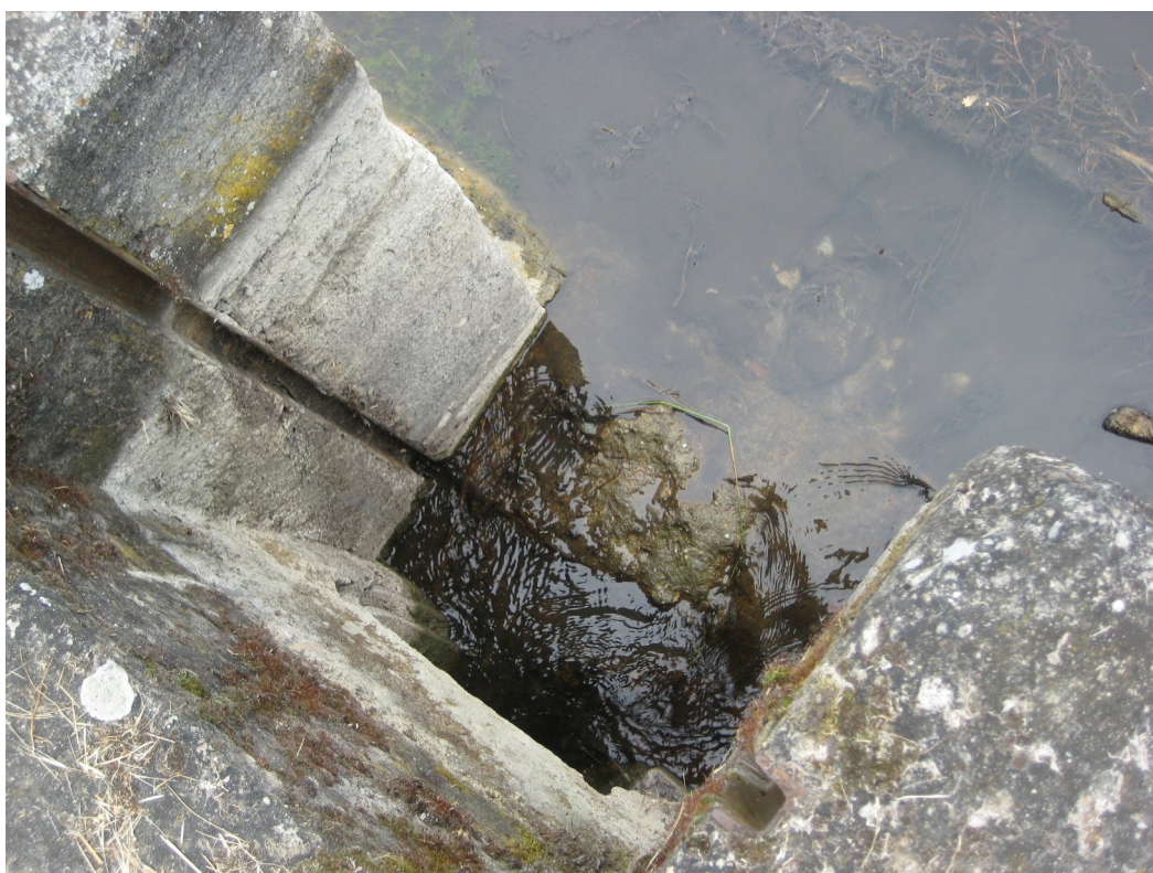
Fot. 5. Wlot do rurociągu
