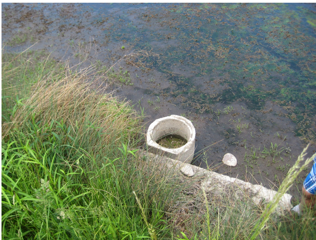
Fot. 6. Osadnik do poboru wody pożarowej
