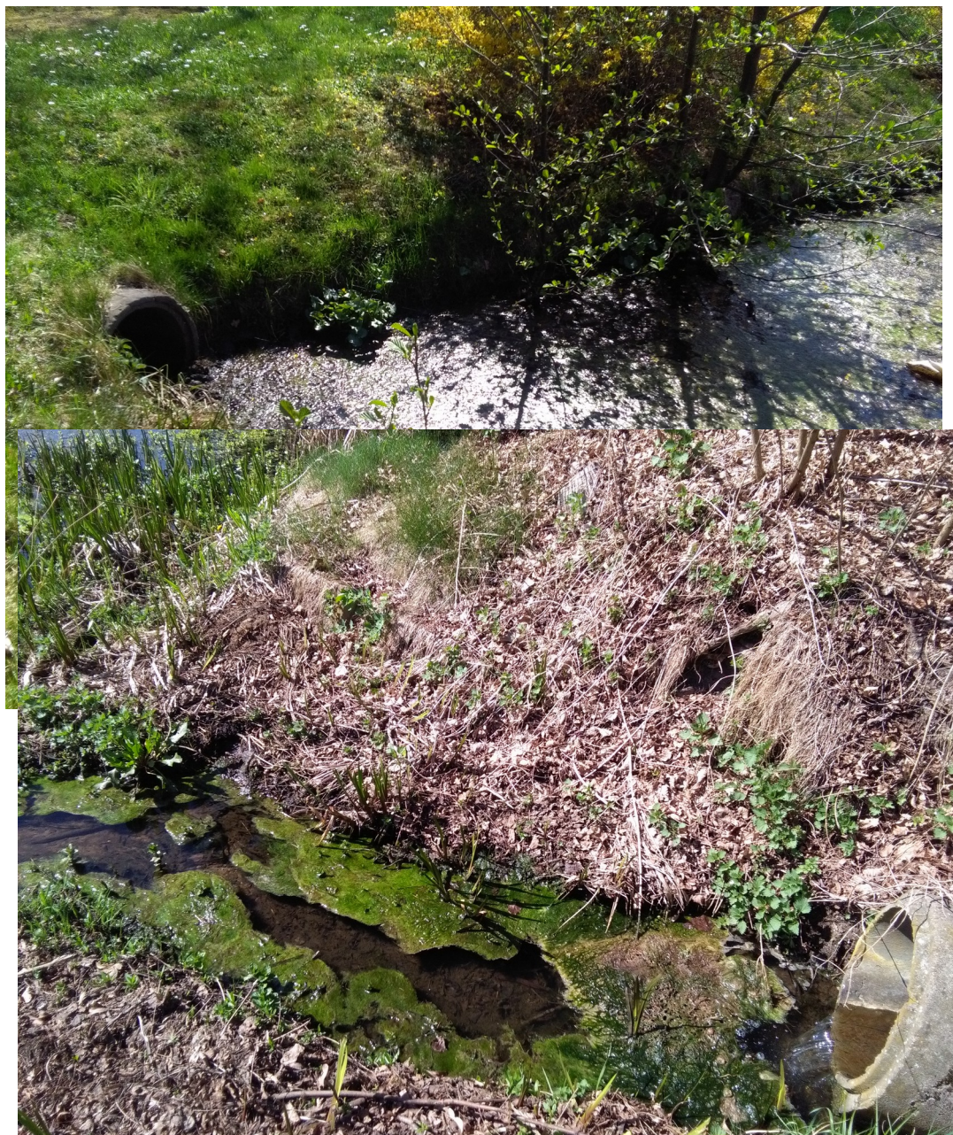
Fot. 8. Wlot betonowy
